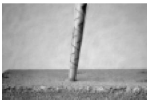
Bohrloch zur Hälfte füllen
