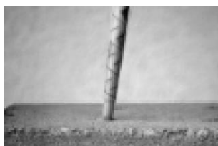
Bohrloch zur Hälfte füllen
